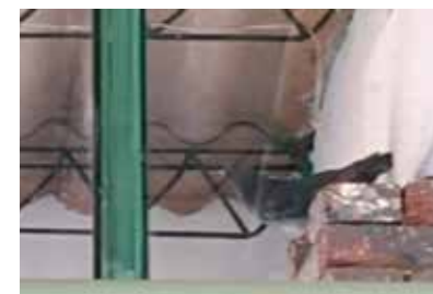
Paloma en el muro del segundo piso
